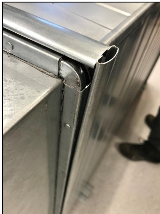
Figur 4: Monterte profiler i skjõt
