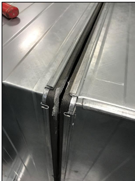
Figur 2: Skjøt mellom kanalseksjonene
