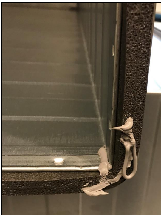
Figur 1: Fugemasse på pakning i hjørne
